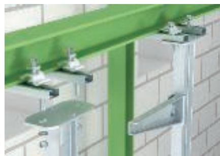
I-takpendel-montering, klemt til stålbjelke med C-profil og kraftig spennklo TKH-L-25. Traseen går tvers av stålbjelken.
