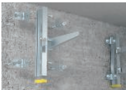
Montering av I-pendel på vegg ved hjelp av monteringsvinkler type 80/55 og boltankere type FAZ II som støtte for flere pendelutligger type AS.
