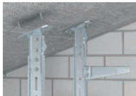
Montering av justerbar endeplate type KI 8 VQP til skrå betongtak med boltankere type FAZ II.
