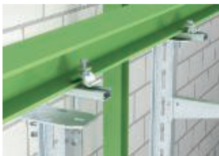
I-takpendel-montering, klemt til stålbjelke med C-profil og kraftig spennklo TKH-L-25. Traseen går langs stålbjelken.
