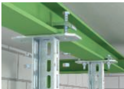
Bruk på vannrett stålbærer
