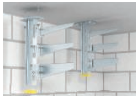
Montering av 3-posisjons kabelbæresystem i betongtak med pendelutligger-montering AS 15, AS 30 og AS 55.
