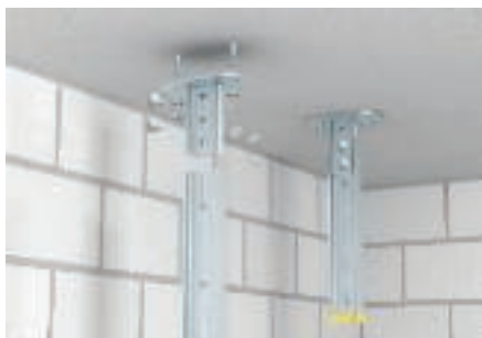
Montering av standard endeplate KI 8 for I-takpendler i betongtak med boltankere type FAZ II.
